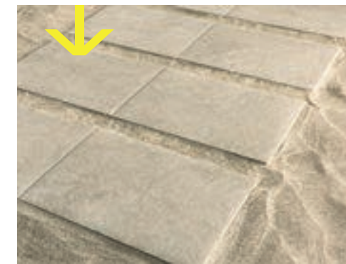
POSA SU SABBIA installation onto sand
