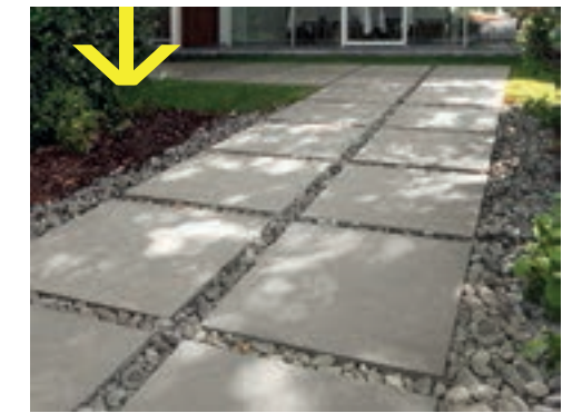
POSA SU GHIAIA installation onto gravel
