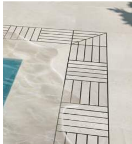
Posa alternata Alternated layout - Pose en caillebotis Verlegung abwechselnd gedreht - Чередующаяся укладка
