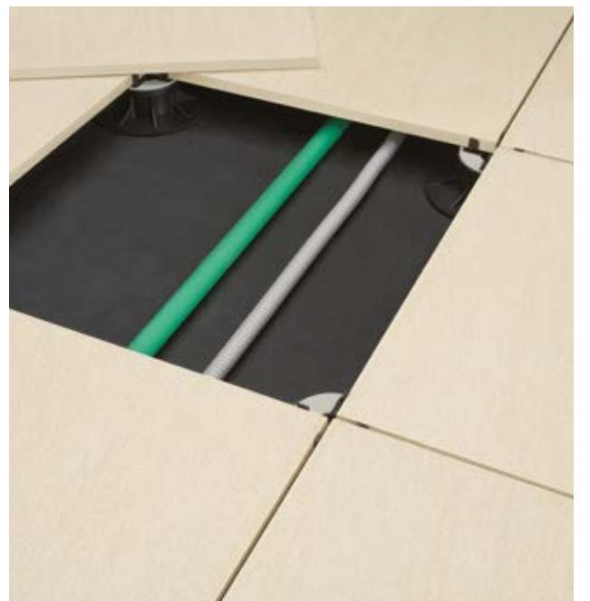
**NELLA MODALITÀ SOPRAELEVATA.** AL DI SOPRA DEL MASSETTO OPPORTUNAMENTE IMPERMEABILIZZATO, LE LASTRE AEXTRA20 VENGONO POSATE A SECCO SU APPOSITI SUPPORTI, CHE NE DETERMINANO LA DISTANZA DI CIRCA 3 MM. SI VIENE COSÌ A CREARE UN VANO TECNICO SOTTO IL PIANO DI CALPESTIO, ISPEZIONABILE SEMPLICEMENTE SOLLEVANDO LE LASTRE.
