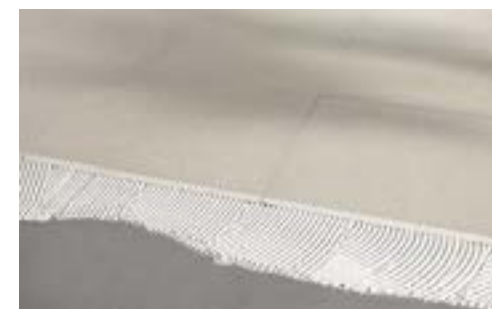
Posa tradizionale con colla . Traditional adhesive installation
