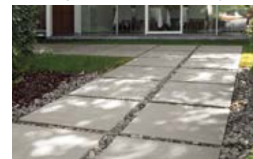
Posa su ghiaia . Installation onto gravel
