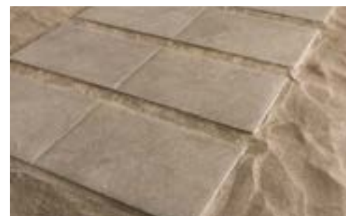
Posa su sabbia . Installation onto sand
